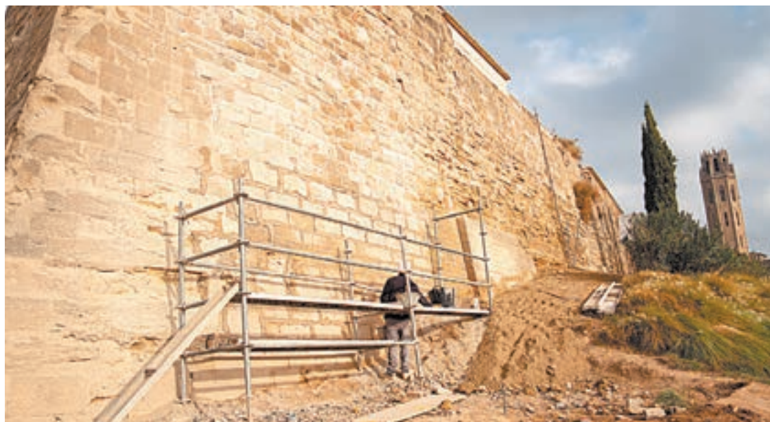
FOTO_ Marc Gómez Imatge de les obres al Baluard de la Llengua de Serp
