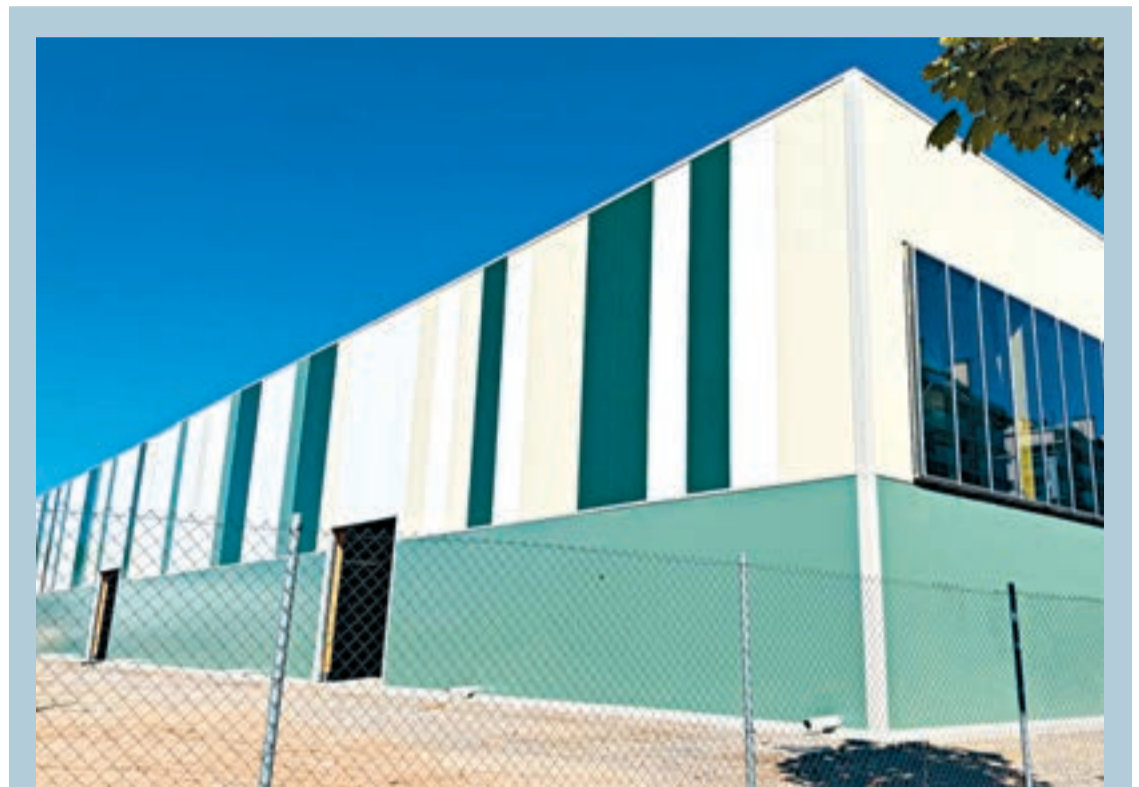
FOTO_RafaPMedina Imatge exterior del nou pavelló de Fira de Lleida
