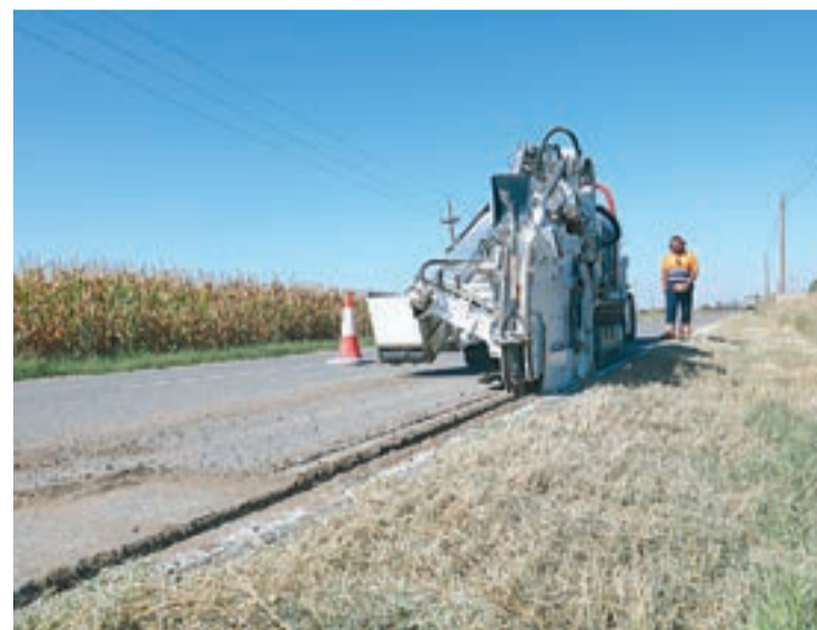
FOTO_A. Mor (ACN) Una màquina obre una rasa
