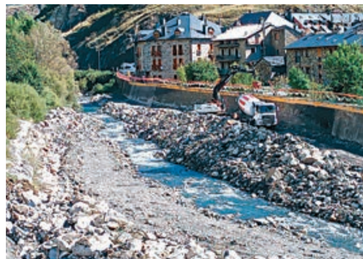
FOTO_ SOS Ribagorza Obres que s'efectuen al riu
