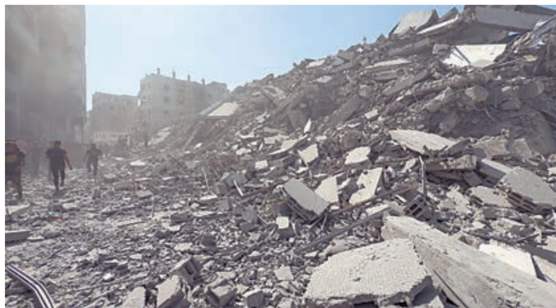
FOTO_EFE Estat en què va quedar l'edifici després de l'atac israelià
