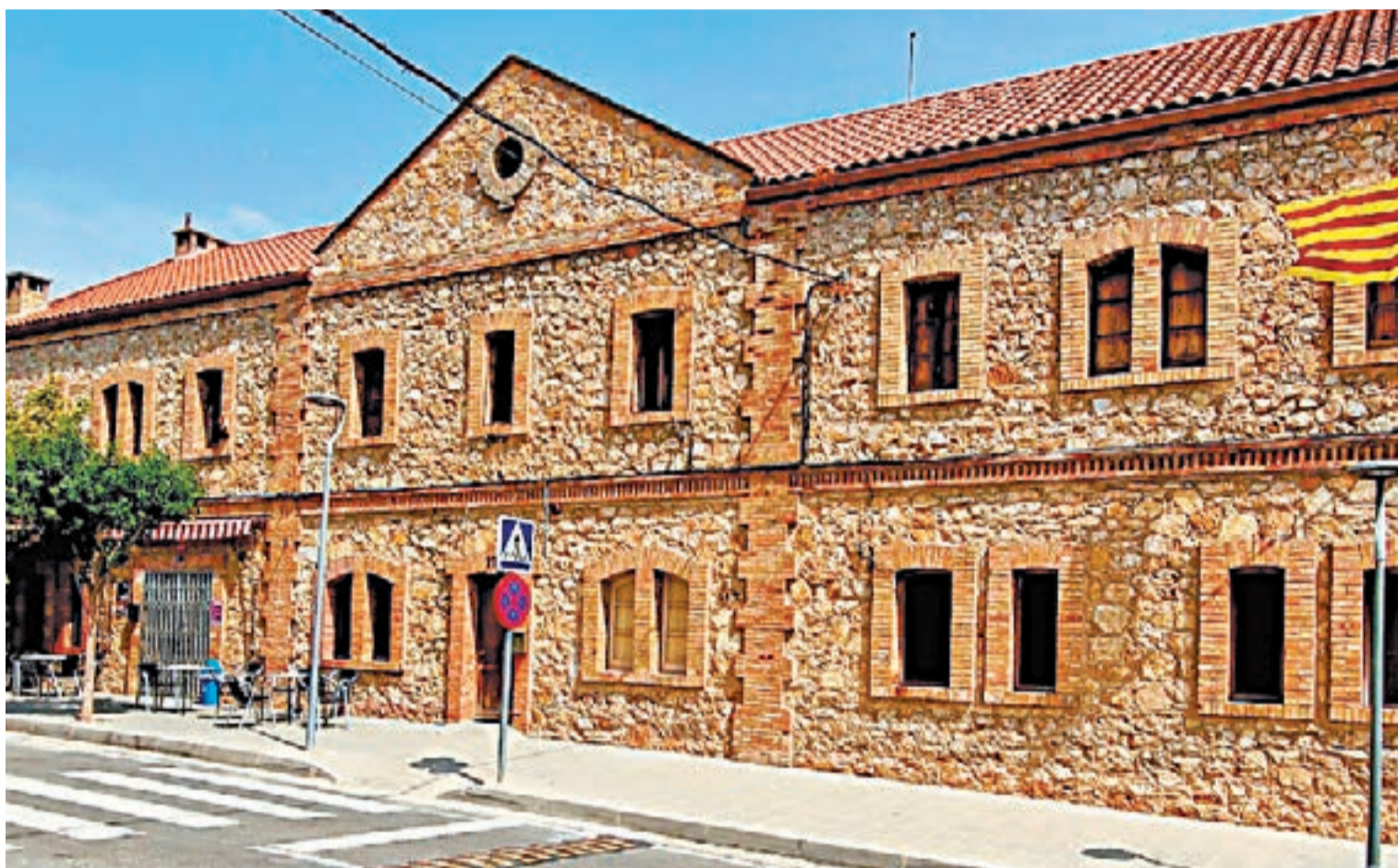
FOTO_ Aj. Camarasa Les obres començaran amb una reforma estructural i acabaran amb l'adequació del pis superior
