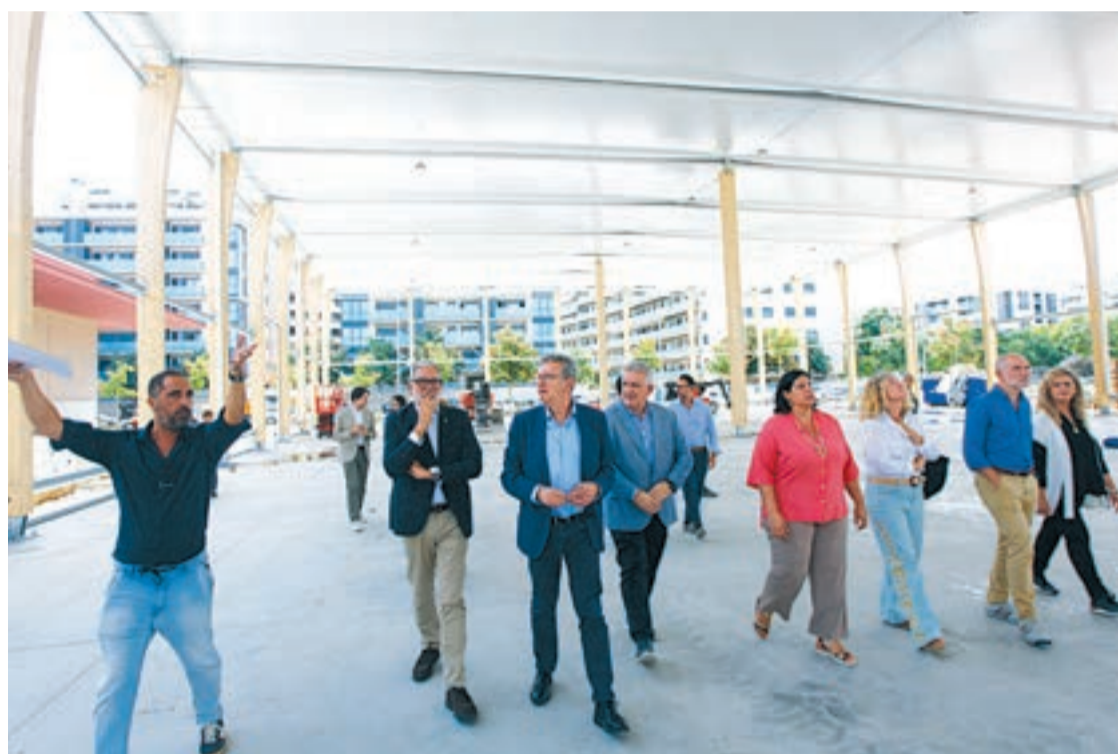
FOTO_Tony Alcántara L'alcalde va visitar les obres del nou pavelló desmuntable
