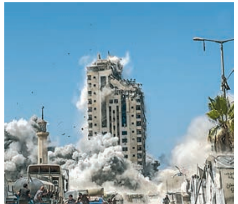
FOTO_ EFE Un dels edificis de Gaza enderrocats ahir
