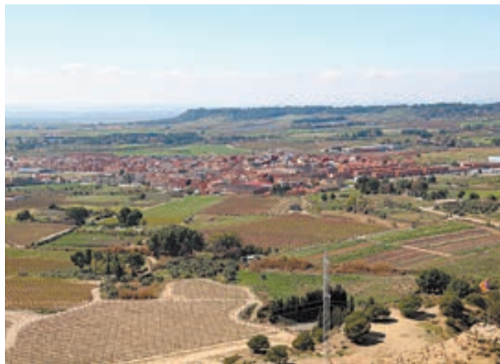
FOTO_ ACN Vista aèria del municipi d'Alpicat, que demana garantir la seguretat dels veïns
