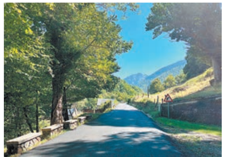
FOTO_ Conselh Generau S'ha reforçat la calçada, que estava erosionada, per millorar la seguretat viària
