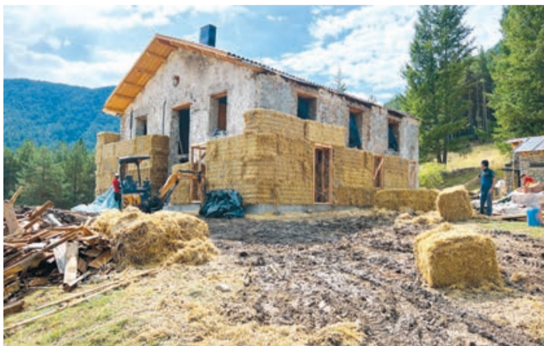
FOTO_ A. L. Cobo (ACN) Vista de les obres de rehabilitació energètica del refugi
