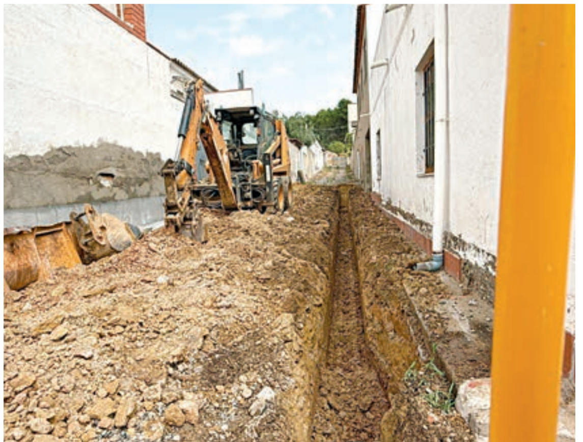
FOTO_ L.M. Una excavadora retira el terra del carrer Segrià durant l'inici de les obres
