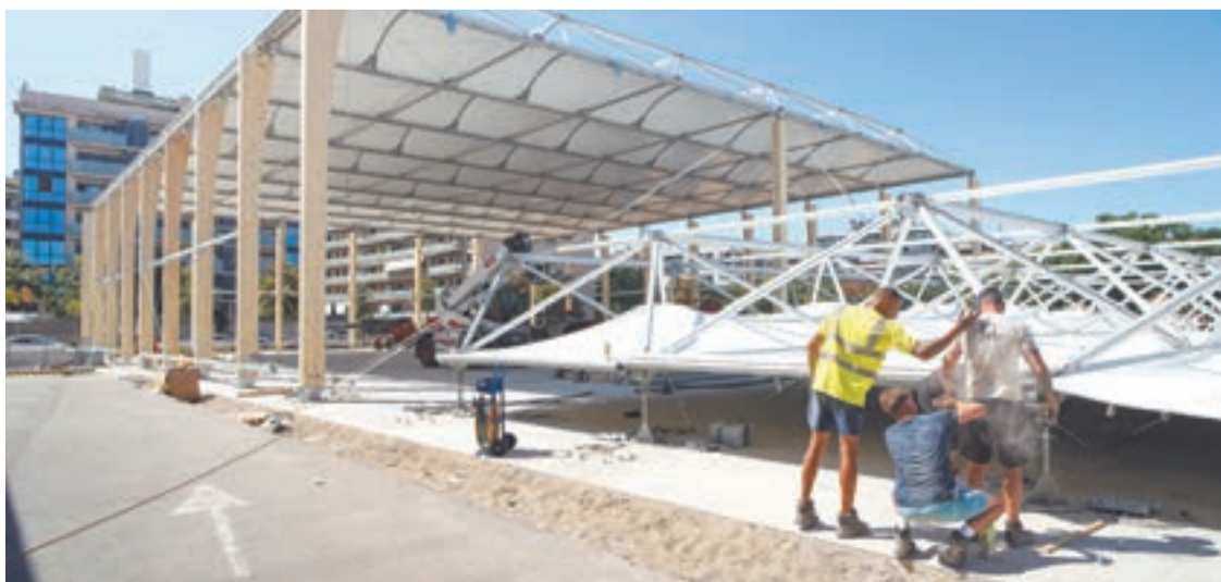
FOTO_Jorge Agustín Les tasques d'instal·lació del nou pavelló es van mantenir ahir per tal d'acabar quan es van comprometre
