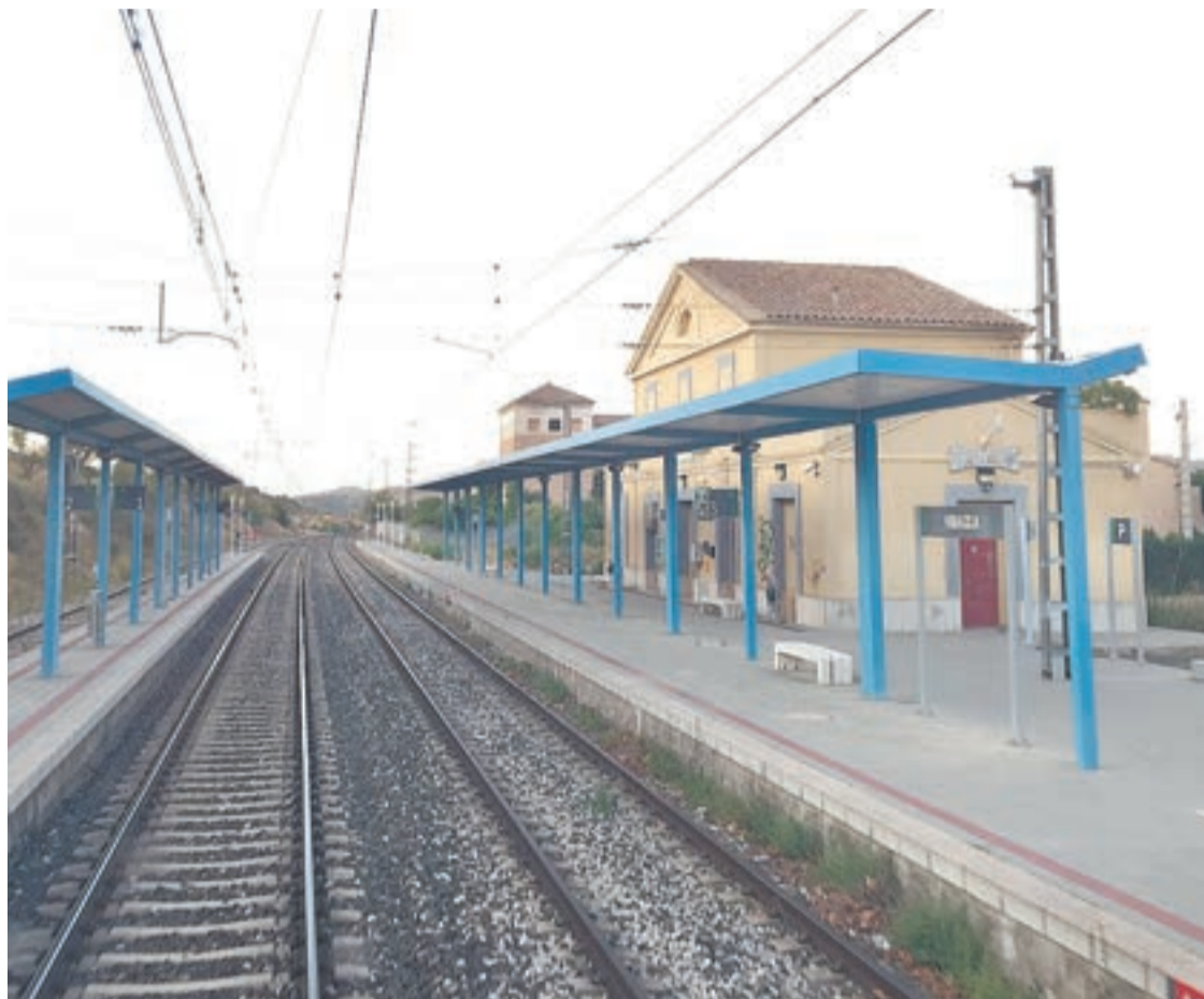
FOTO_L.M. Imatge de l'estació de tren de Vinaixa, a la comarca de les Garrigues
