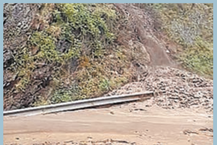
FOTO_Carlos Flores Una esllavissada va obligar a tallar la carretera C-13, al terme de Llavorsí
