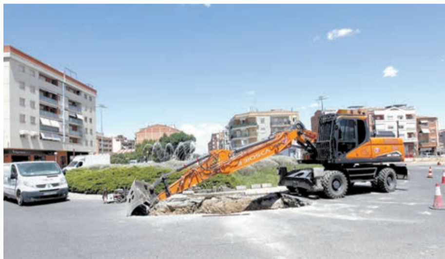
FOTO_ Tony Alcántara L'excavadora a la rotonda fa el forat a la calçada
