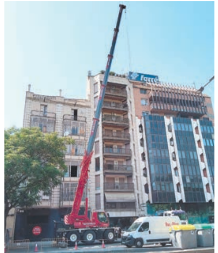
FOTO_D.A. La grua fent tasques sobre la vorera
