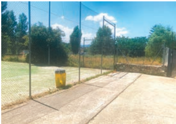
FOTO_ Aj. de la Seu Lloc on es duran a terme les obres
