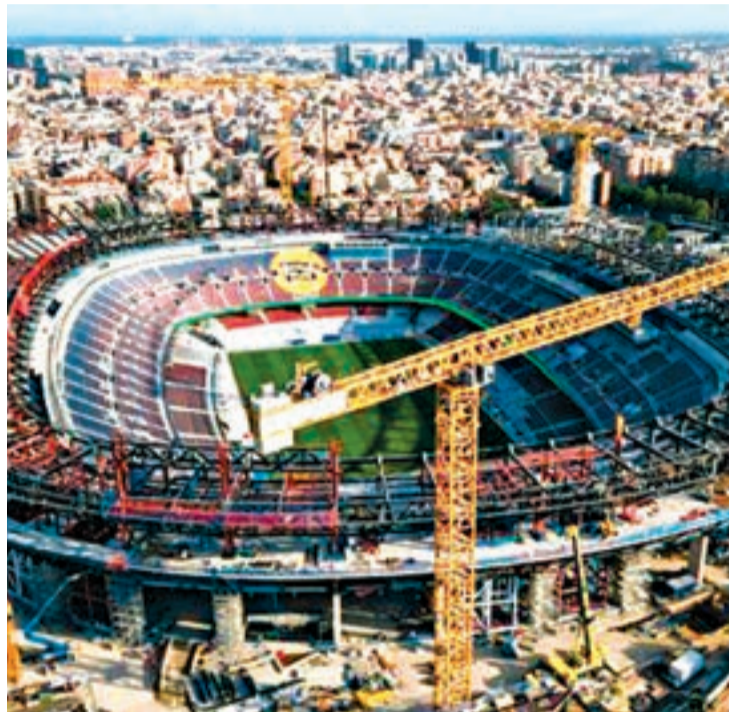
FOTO_EFE El Camp Nou, en obres
