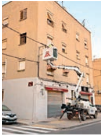
FOTO_ L.M. Operaris reparant ahir el subministre
