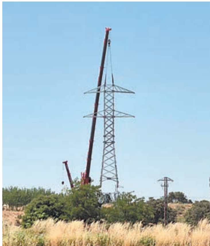
FOTO_ L.M. La torre instal·lada ahir al migdia
