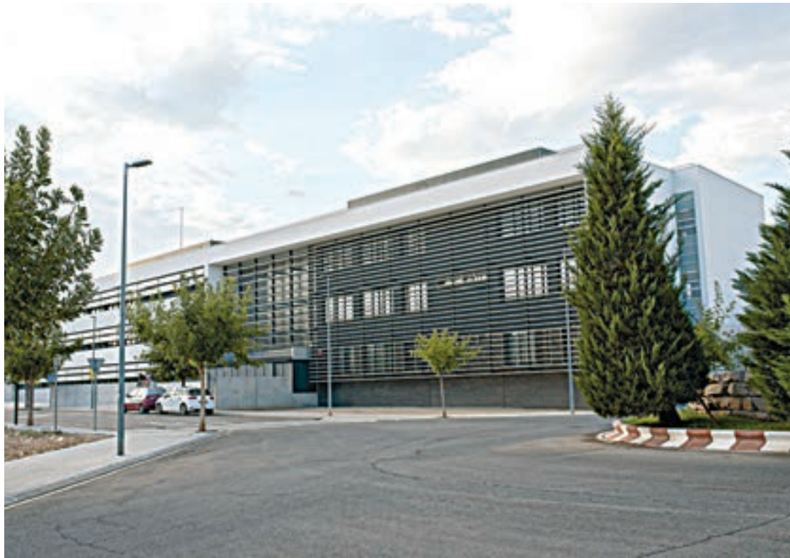
FOTO_ Aj. Torrefarrera Imatge de la façana de l'institut Joan Solà de Torrefarrera
