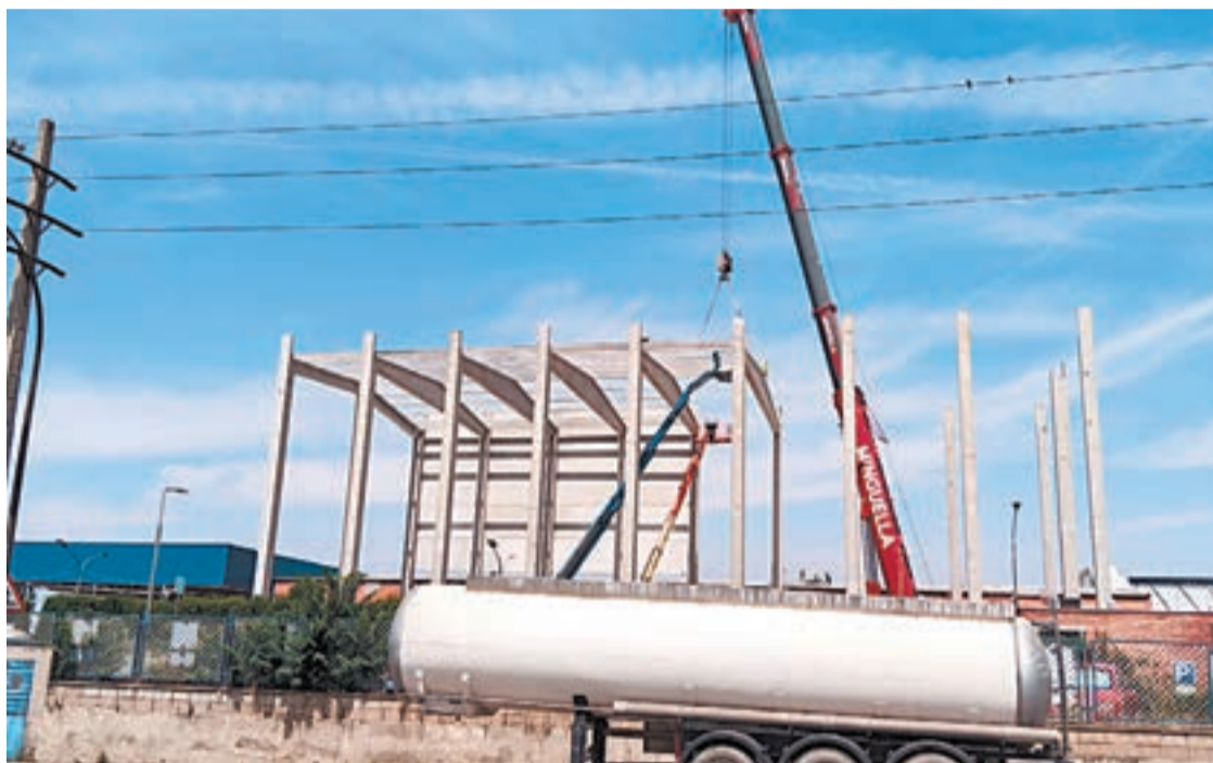
FOTO_ D.A. Estructura de formigó que s'està muntant al polígon El Segre
