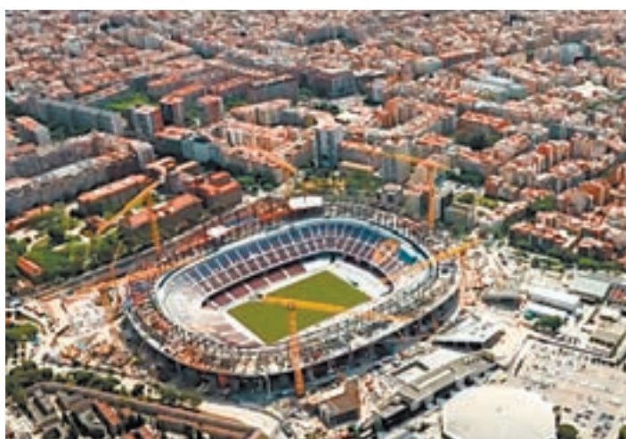
FOTO_ FCB Vista aèria de les obres de l'estadi
