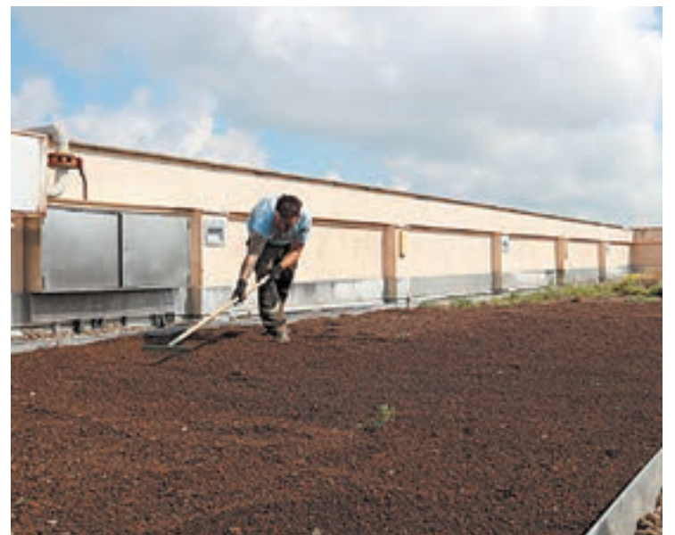
FOTO_ Alba Mor (ACN) Un operari prepara el terreny per habilitar una coberta verda a la ciutat de Lleida
