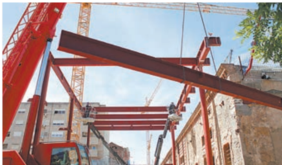
FOTO_ Tony Alcántara Una grua eleva les bigues metàl·liques
