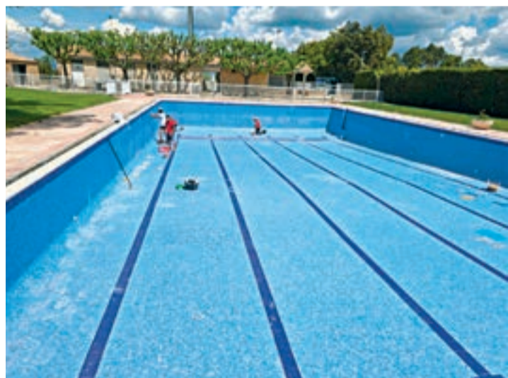
FOTO_ Aj. Sant Ramon Operaris treballant a les piscines
