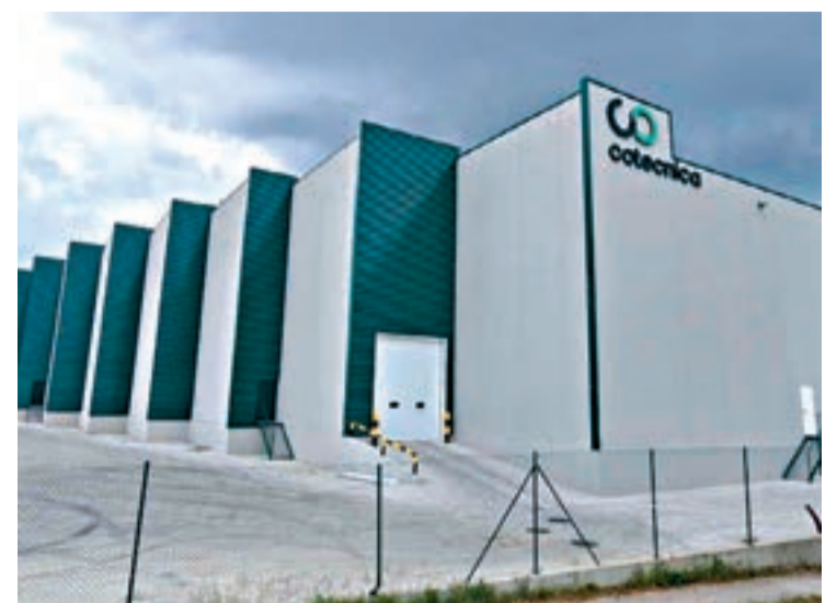
FOTO_Cotecnica Magatzem exterior a Bellpuig
