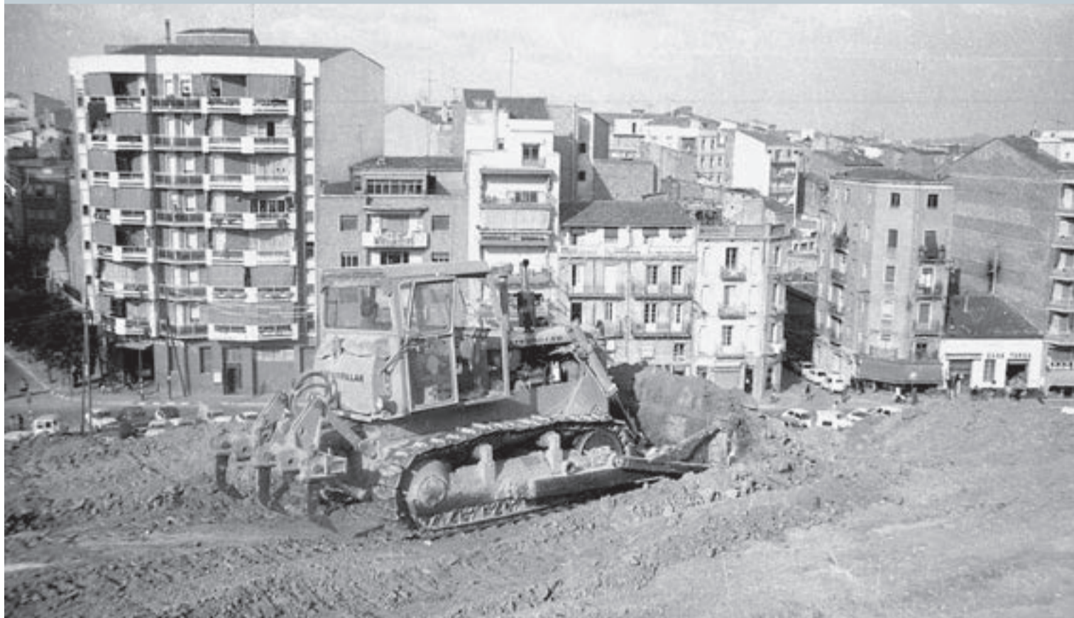
Una màquina excavadora remou la terra al vessant nord del Turó de la Seu Vella / Fons Gómez Vidal (sense datar)
