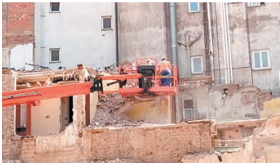
FOTO_ D.A. Els operaris ahir durant l'enderrocament de l'edifici
