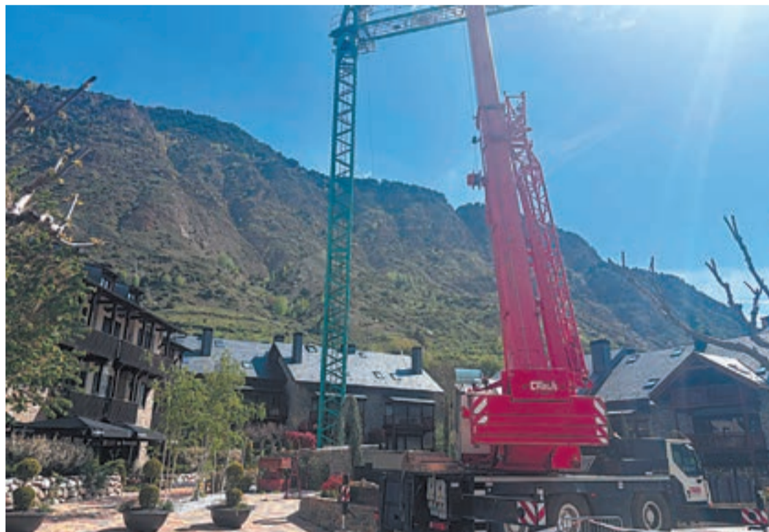
FOTO_L.M. Moment en què es desmunta la grua utilitzada per la construcció de la Pleta
