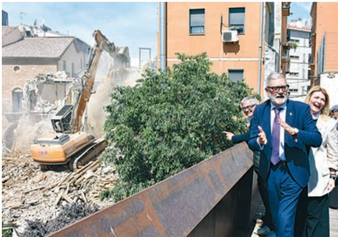
FOTO_ Irene Nyemeck Tasques d'enderroc dels edificis al carrer Cavallers
