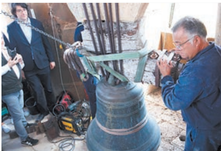
FOTO_Anna Berga (ACN) Treballs per baixar la campana
