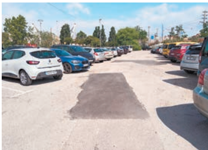
FOTO_D.A. La Paeria ha asfaltat trams en mal estat de l'estacionament, prop del pont de Príncep de Viana
