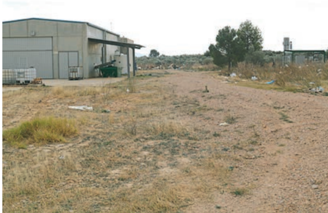
FOTO_ Gencat La planta de biogàs al costat de la planta de tractament de llixiviats
