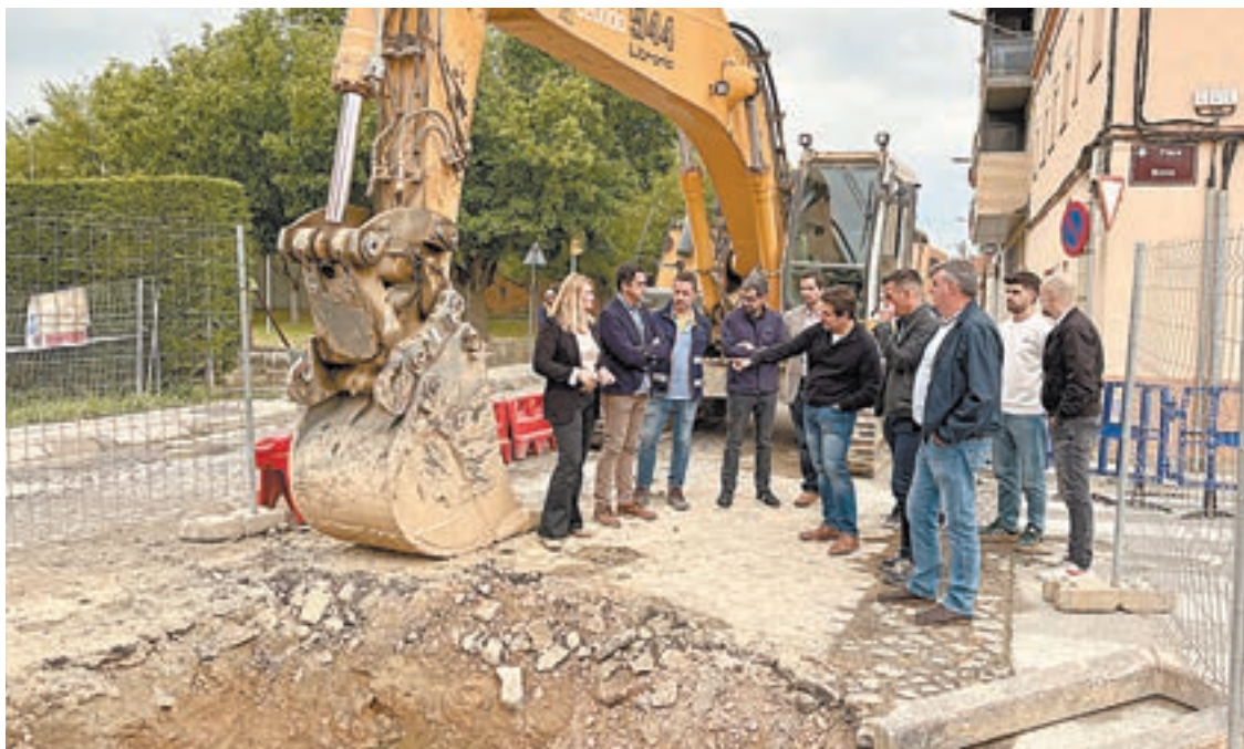
FOTO_ La Paeria La tinenta d'alcalde Begoña Iglesias va visitar les obres a Llivia
