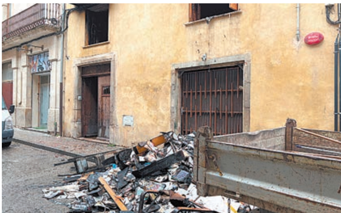
FOTO_ Alba Mor (ACN) L'edifici cremat amb tot de material calcinat per les flames
