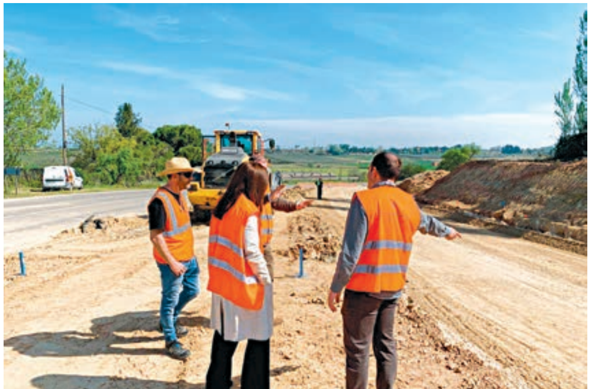
FOTO_ DdL Els treballs per millorar el ferm en aquesta carretera ja han començat
