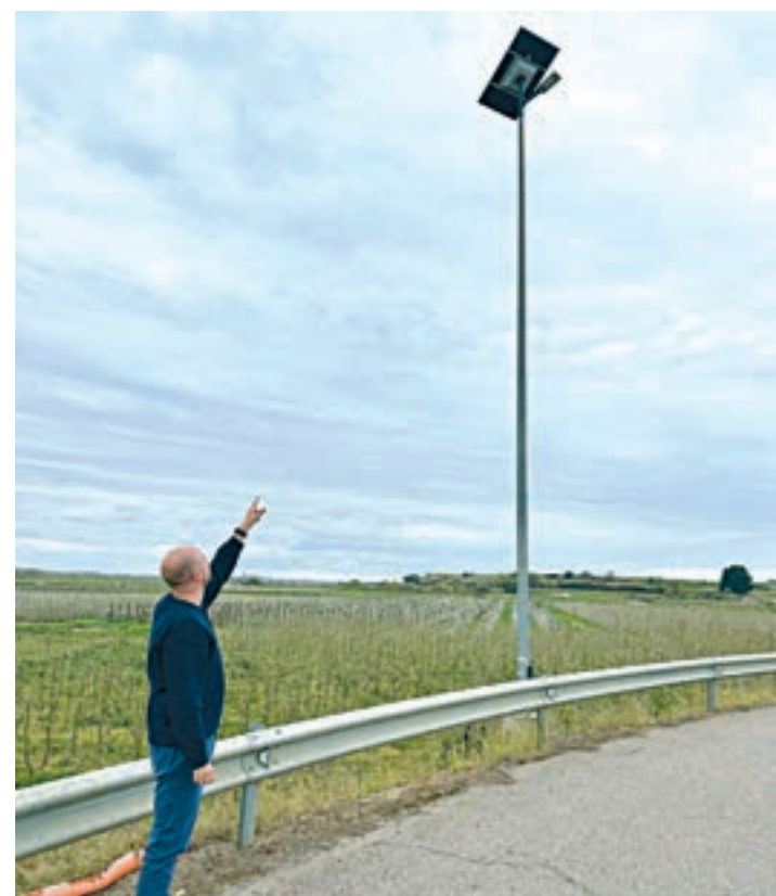
FOTO_ Aj. Corbins Un dels nous fanals instal·lats
