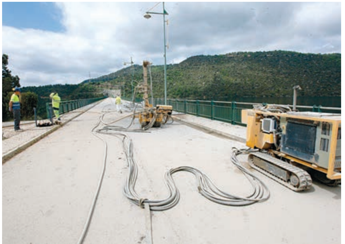
FOTO_ Tony Alcántara Vista de la part superior de la presa de Rialb
