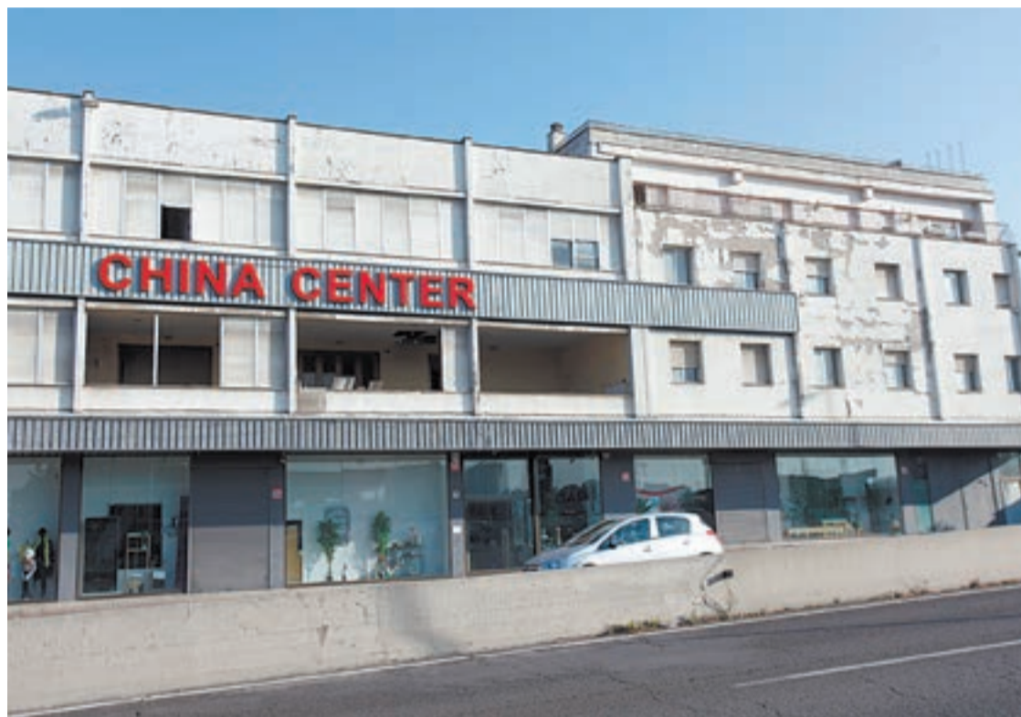
FOTO_Tony Alcántara Immobile de l'antic hotel Ilerda, situat a la carretera LL-11
