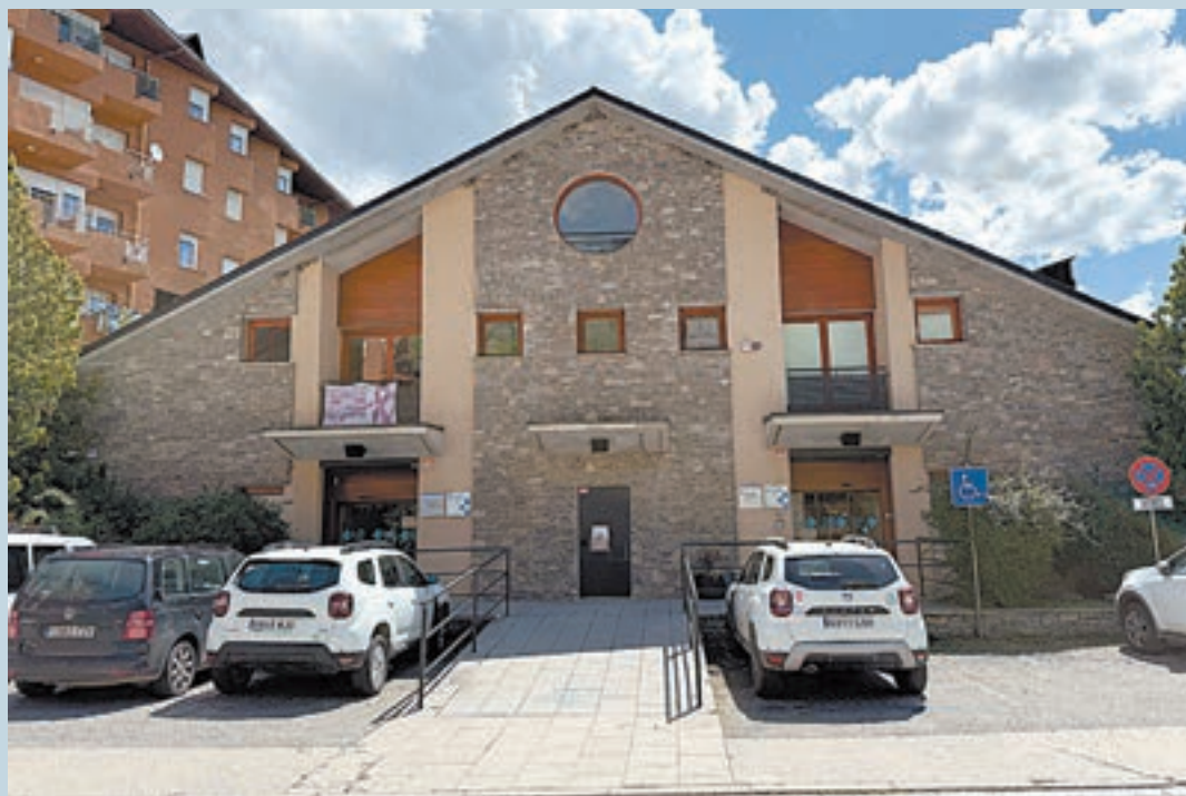
FOTO_ACN La comissaria té un sistema alternatiu d'energia en cas d'apagada
