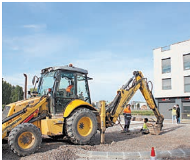
Aj.del Palau Obres de la rotonda del carrer Urgell
