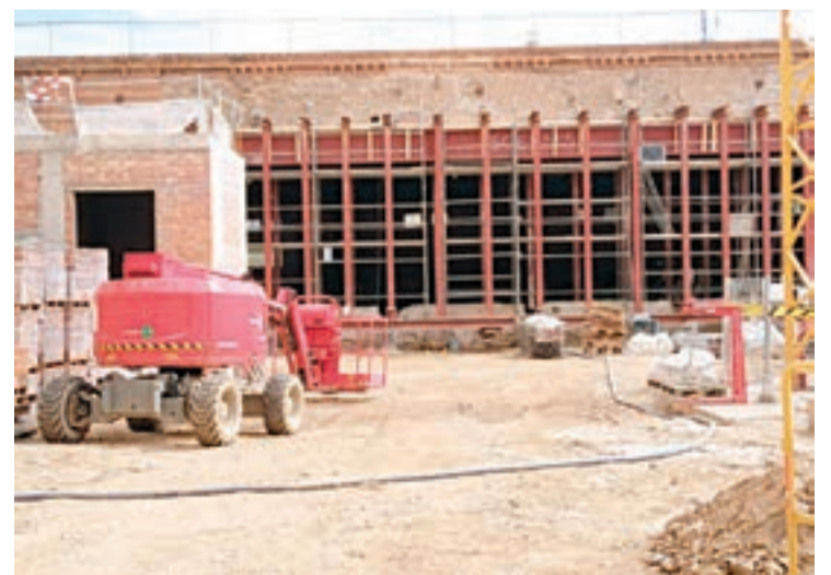
FOTO_D.A. L'estructura metàl·lica ha permès fer el nou accés a la futura estació
