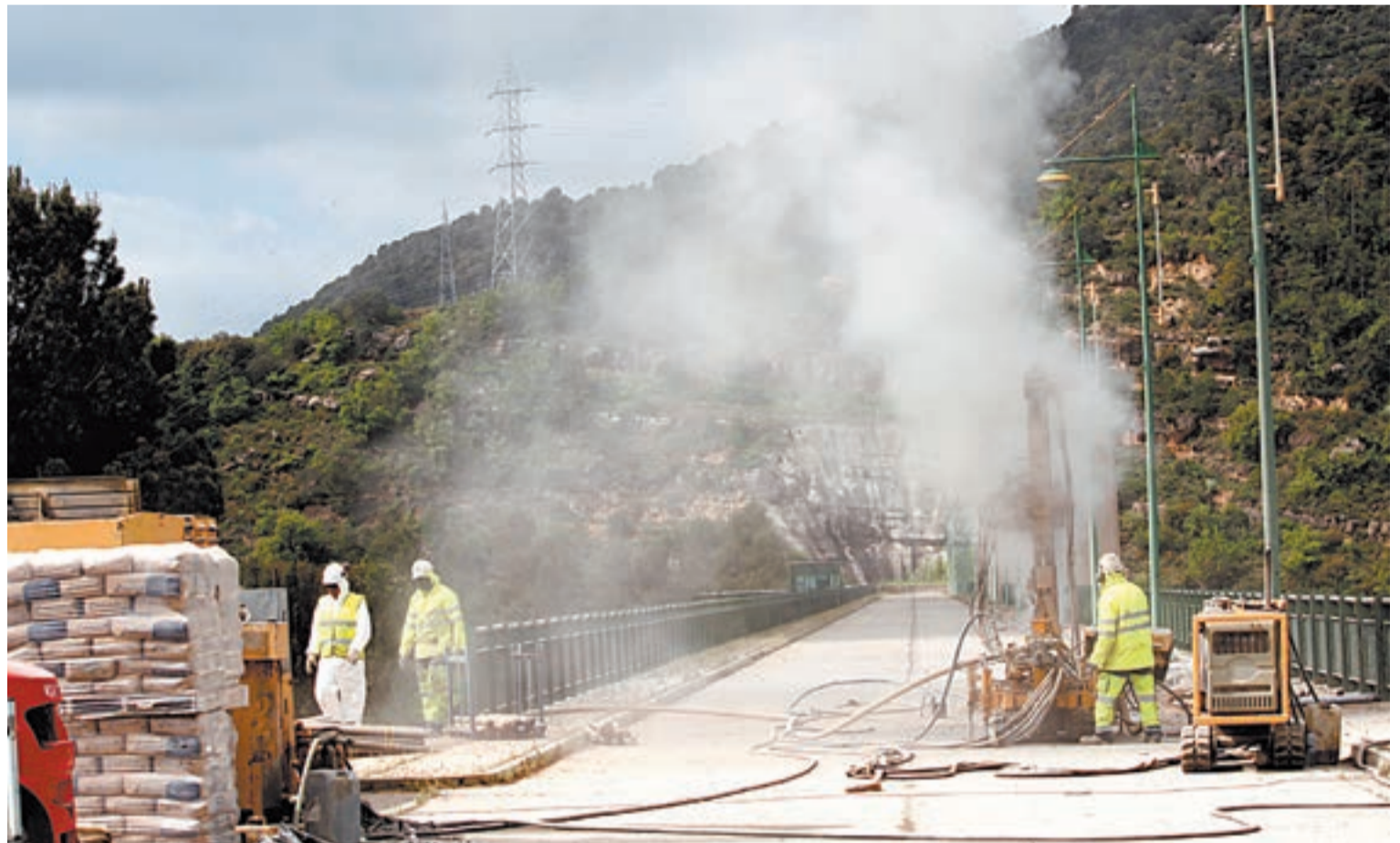
FOTO_Tony Alcántara Operaris realitzen perforacions des de la part superior de la presa que localitzar la fuga
