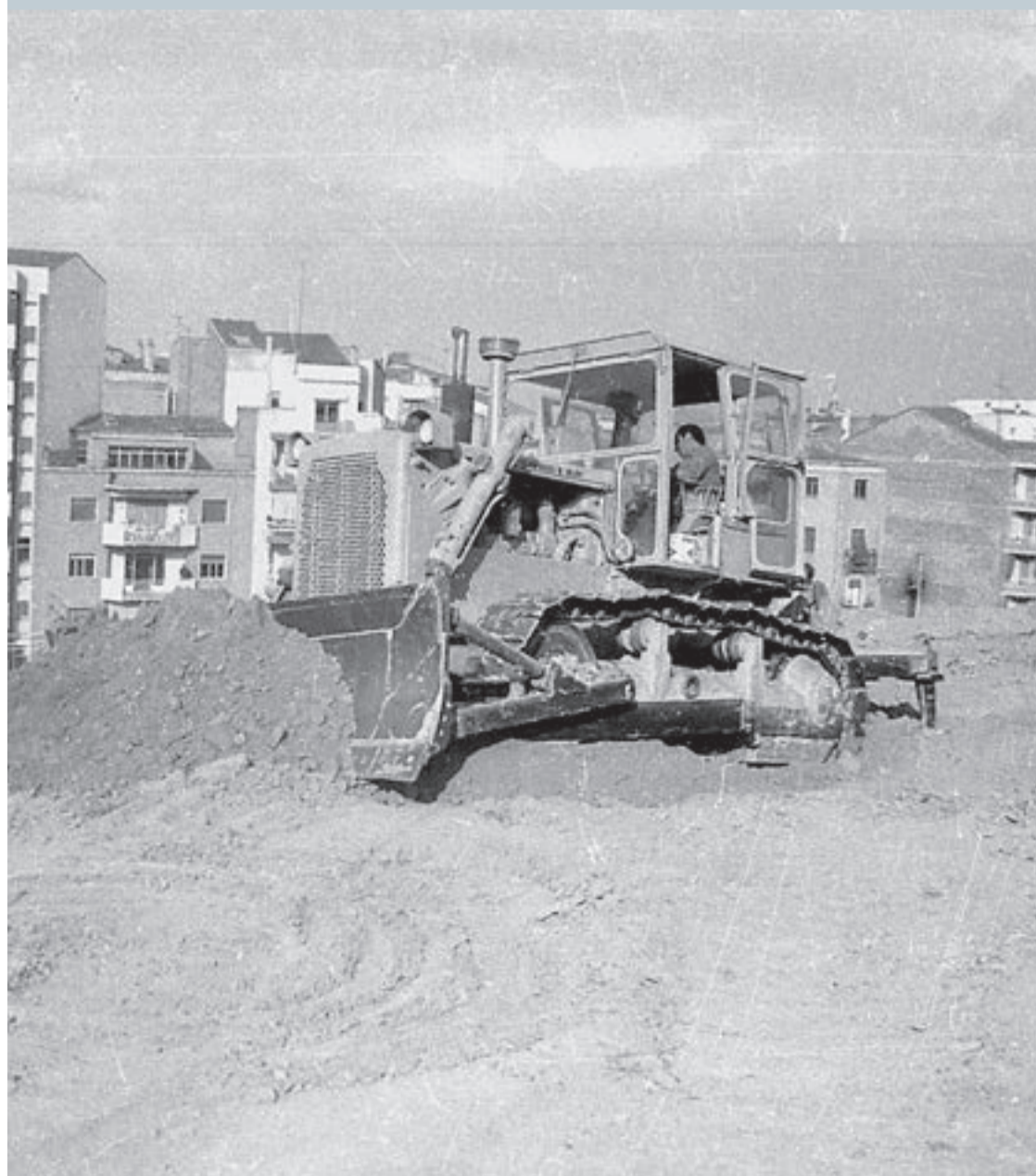
Una excavadora remou la terra al vessant nord del turó / Fons Gómez Vidal (sense datar)
