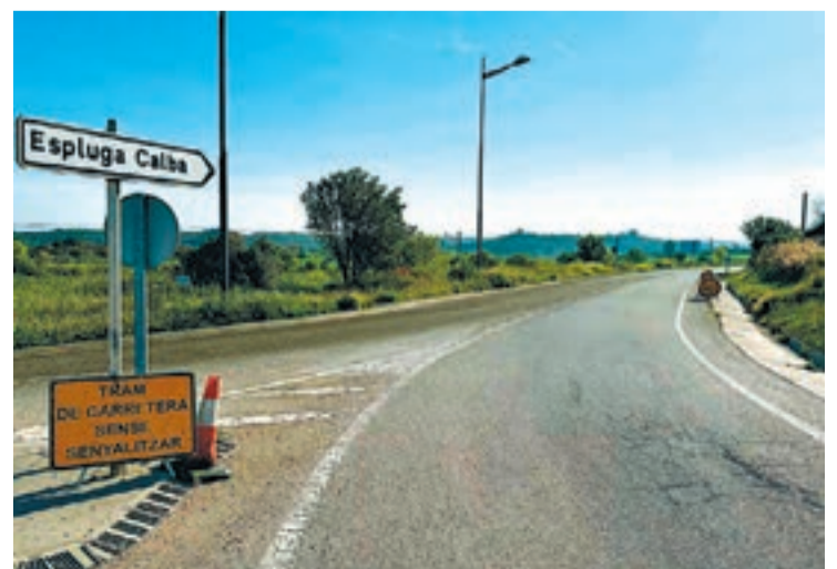
FOTO_ Diputació Tram de la via on s'ha actuat
