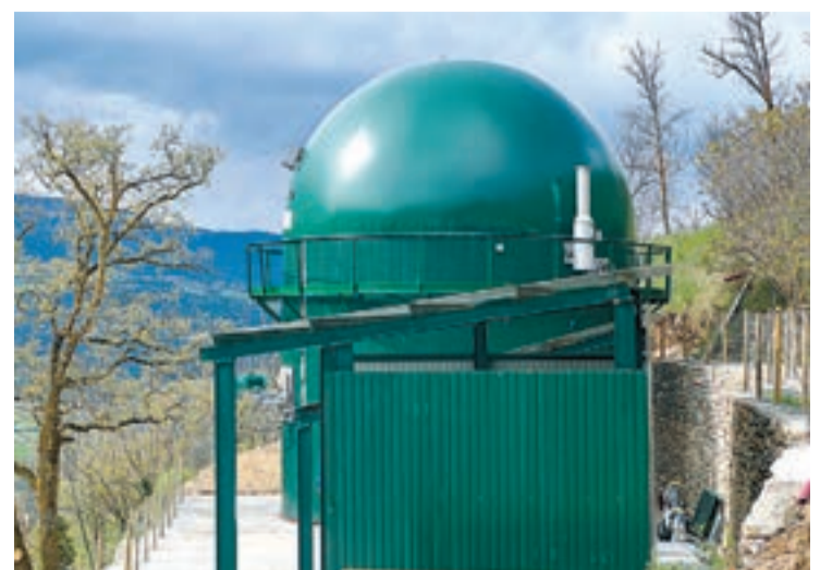
FOTO_ACN La planta recentment construïda
