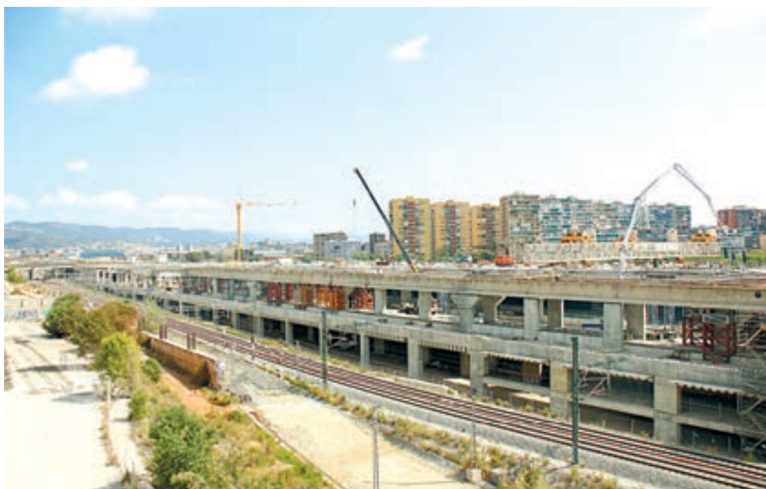
FOTO_ ACN Vista aèria de les obres de la futura estació de La Sagrera de Barcelona
