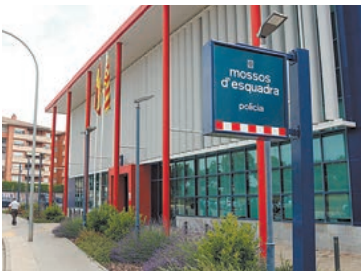
Exterior de l'edifici de la comissaria dels Mossos d'Esquadra a Lleida
