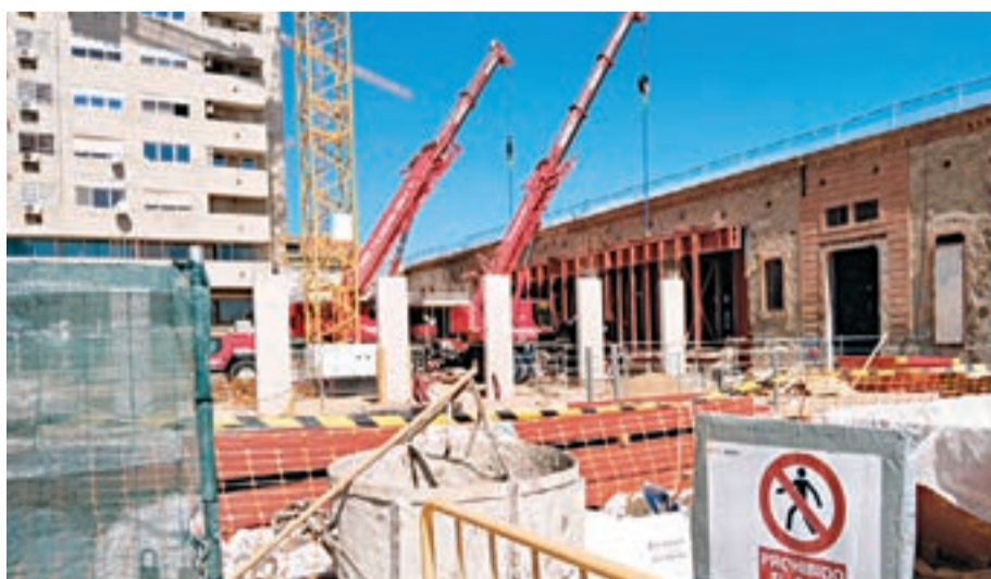
FOTO_ D.A. Tasques per la construcció de la futura estació de busos
