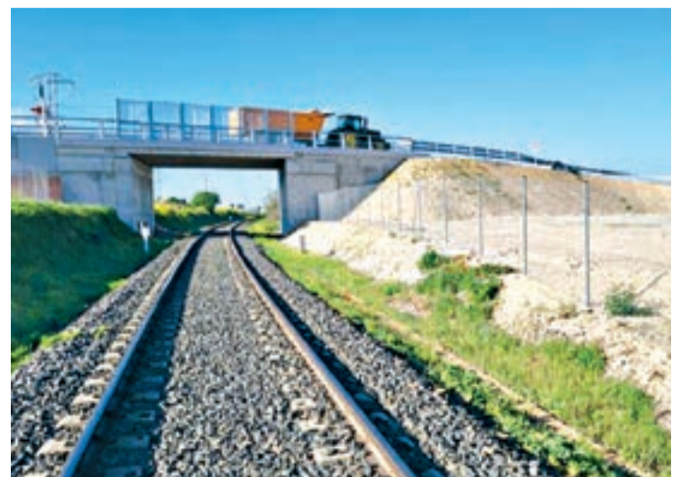
FOTO_ Ferrocarrils El nou pas elevat ja està en servei
