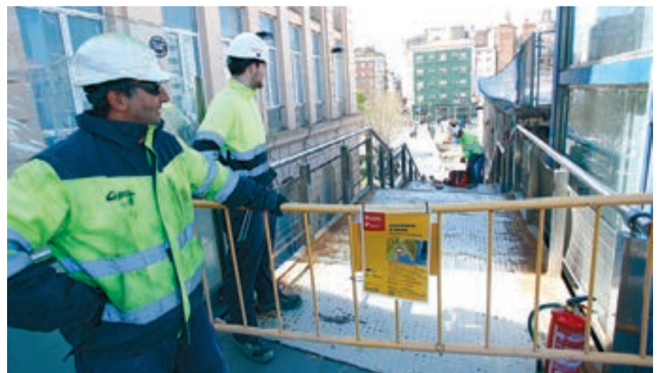
FOTO_ Tony Alcántara Treballs a l'accés a la passarel·la de l'estació
