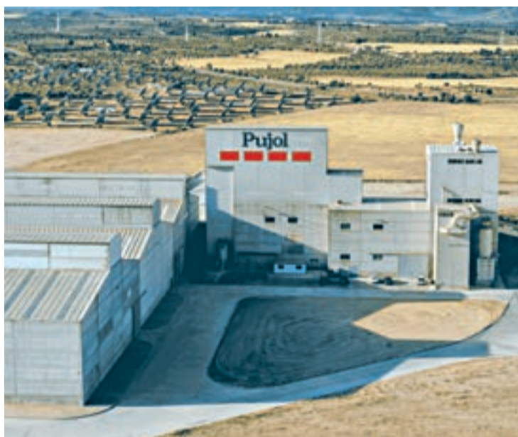
Planta de ciment de Prefabricats Pujol a les Borges Blanques FOTO_ L.M.
