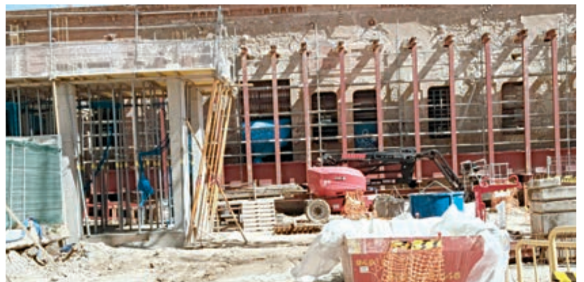
FOTO_ D.A. Estructura metàl·lica instal·lada per les obres de la nova estació de busos
