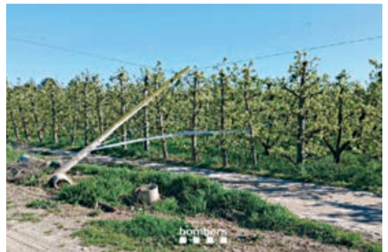
FOTO_ Bombers Pal telefònic caigut al Camí de Grenyana
