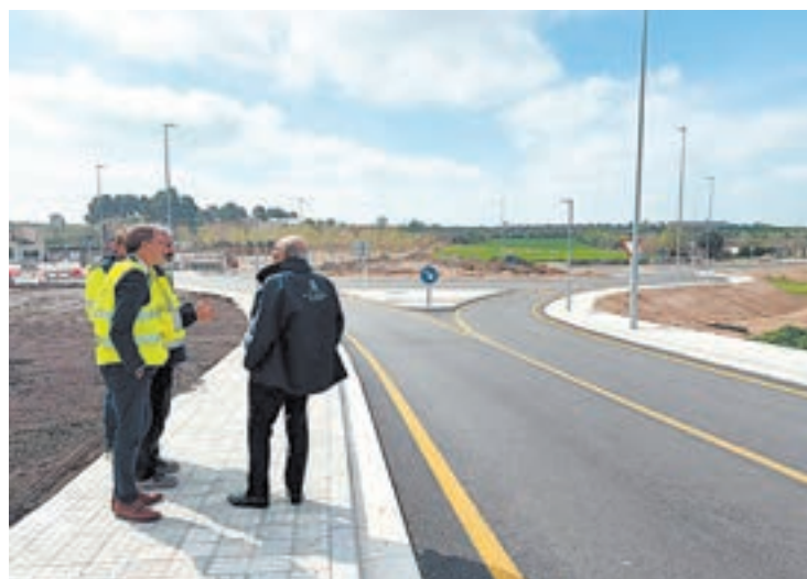
FOTO_ Subdel. Gov. Jose Crespín va visitar les obres
