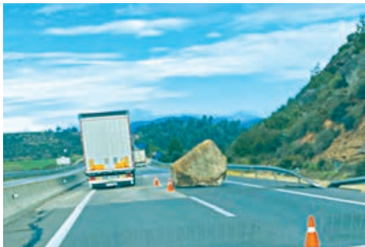
FOTO_ ACN Imatge de la pedra que va caure ahir a l'Eix Transversal, a la zona de Rajadell
