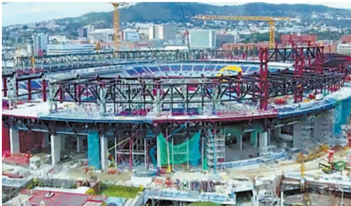
FOTO_ L. M. Les obres del nou estadi continuen
