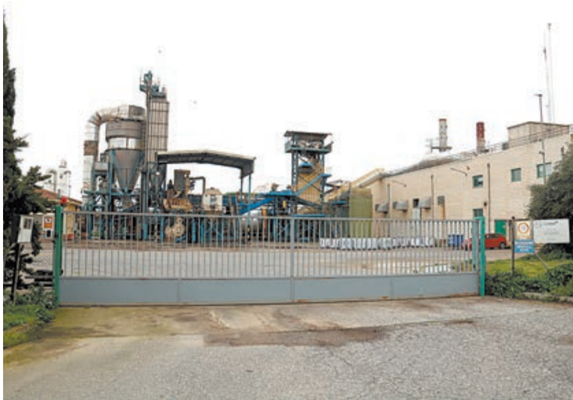
FOTO_ACN Planta de tractament de purins d'Alcarràs que haurà deixarà de funcionar
