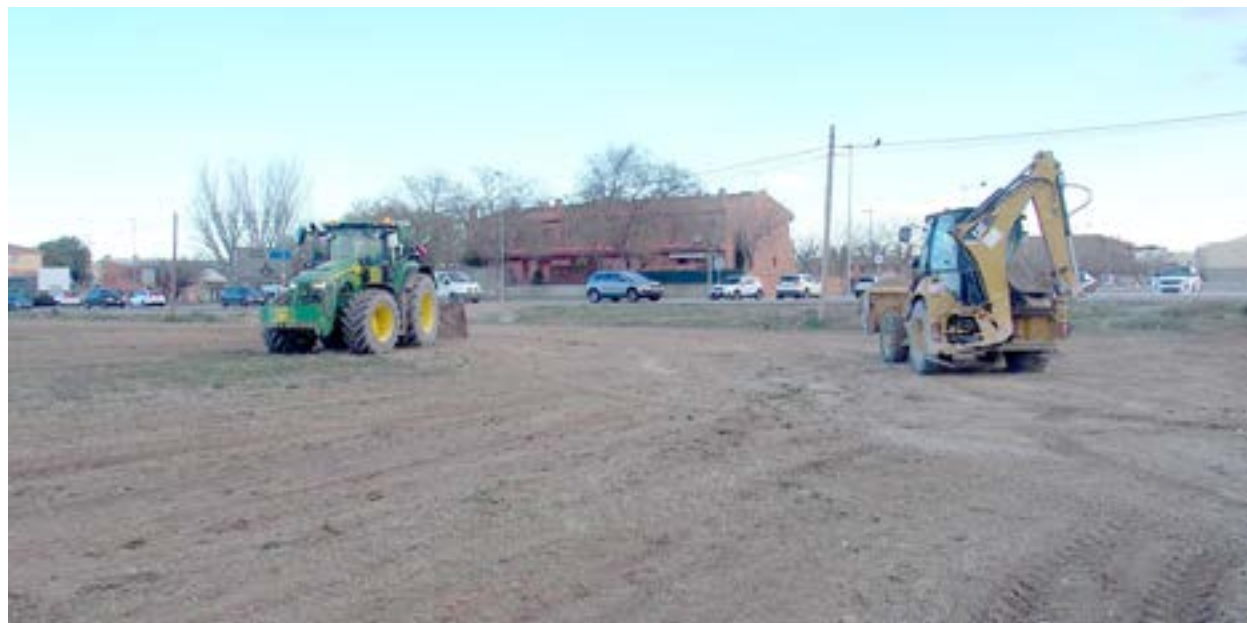
Fira de Mollerussa / Obres per habilitar el nou espai d'aparcament a Ronda Ponent
